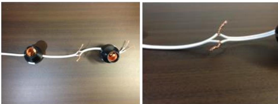
式、壺のあとそれぞれをビニルテープで巻く。このとき露出した銅線が完全に絶縁されるようにする。銅線が少しでも見えているとアウト。貼り方のコツは銅線部分を包み込むように貼ると良い。
